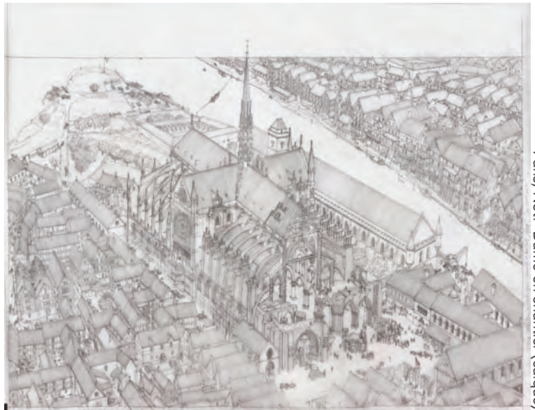
Paris, Notre-Dame en chantier (calque)
